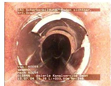
[Bilder 4 bis 6: Kanalschäden – li.: einwachsende Wurzeln, Mitte: einragender Stutzen, re.: Einbruch]
