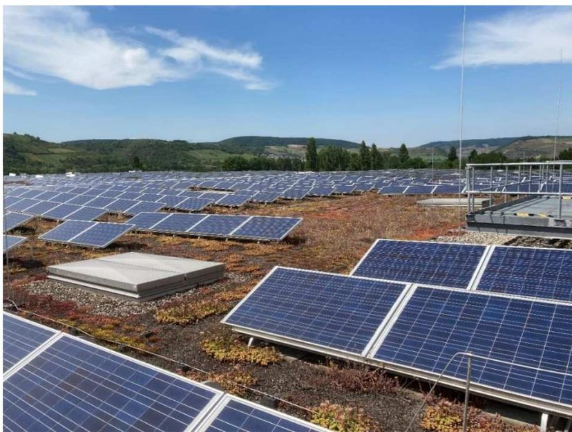
**Foto 1:** Beispielhafte Darstellung einer extensiven Dachbegrünung in Kombination mit PV-Anlagen auf einer gewerblich genutzten Halle (Fotoaufnahme: ÖKOPLANA)
