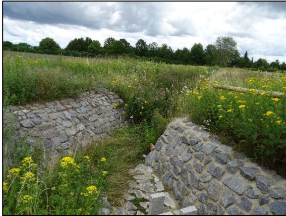
Abb. 14: Gemauerte Einfassung zwischen den beiden Teilgräben. Blick nach Nordosten (Aufnahme 07/2021)
